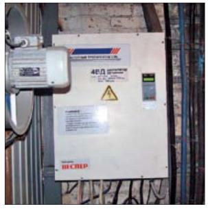
установлен первый Веспер серии 8000, мощностью 15 кВт на насосе высокого давления
