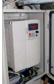
Z-образная тестомесилка пряничного теста и преобразователь Веспер при ней, управляющий двигателем. Ему задается две скорости, потому что в определенный момент легче, а в другой тяжелее провернуть тестовую массу
