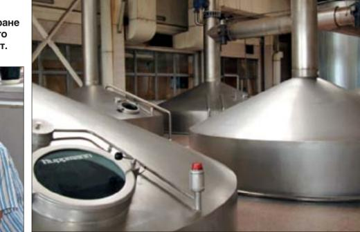
На фото слева: заместитель начальника службы электроавтоматики Голубь Андрей Иванович. На фото вверху: На этих чудо-кастрюлях (чаны для сусла) установлены двигатели мощностью 10 кВт и преобразователи Веспер 15 кВт. которые предохраняют двигатель от поломок, перегрузок, снижают пусковые токи
