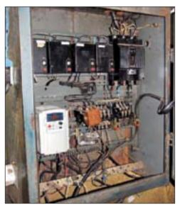
затем включение насоса - и обрывается вал крыльчатки. Поставили преобразователь - прошло 1,5 года, ничего не срывает.
